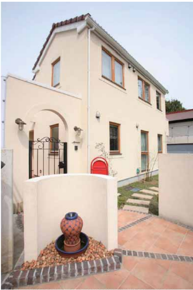
フランス調の露上庭園に木製3層ガラス窓の扉。窓の形状に変化をつけることで、空間の広がりを際立たせる工夫を施している
